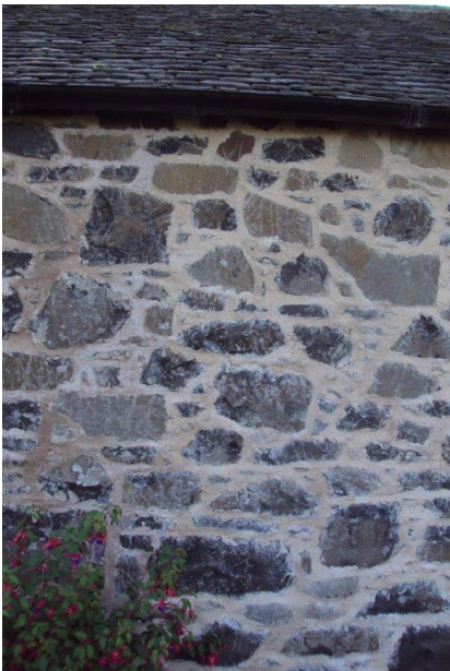
Repointing using a lime mortar.
